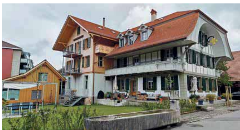
Im ehemaligen Restaurant Kreuz entsteht ein neuer Kulturraum. Bild: AW
