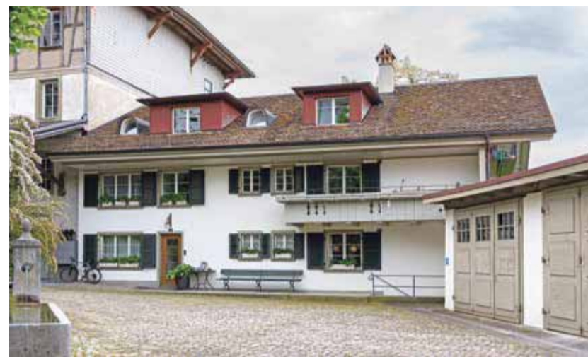
Dachstock auf dem Areal der Schlossmühle. 2012 liess die Familie Aeberhard den Dachstock des Wohnhauses an der Mühlestrasse 35 dendrochronologisch untersuchen. Dabei stellte sich heraus, dass dieser um 1856 erbaut wurde, wobei auch hier wie beim Bürgenstock ältere Hölzer verwendet wurden, so der Riegständer von 1811. Bild: S. Mathys
