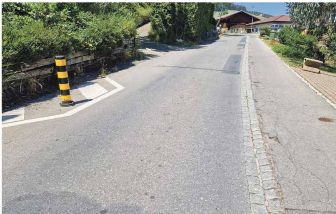
Der Mehrzweckstreifen weist durch die Mehrbelastung deutliche Spuren auf.
