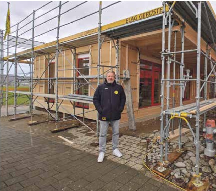
Baustellenbesuch mit Clubpräsident Christoph Schneider.
